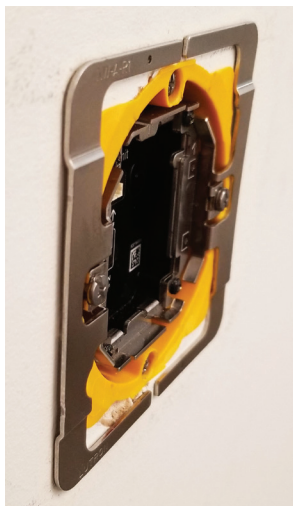
正确 适配器平靠墙壁。
