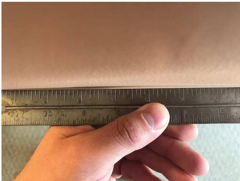
用于评估墙壁平整度的直尺照片。
