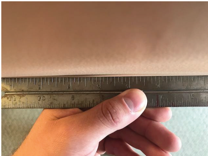
Foto van het gebruik van een liniaal om de vlakheid van de wand te controleren.
