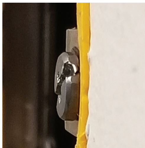
INCORRECTO El tornillo de cabeza cilíndrica sobresale más allá de la caja montaje, y no está al ras con la misma.
